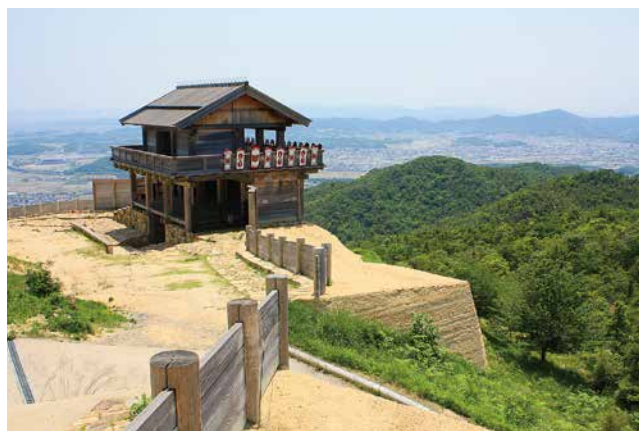
復元された古代の山城である鬼ノ城跡（岡山県総社市）城門 (写真提供：岡山県観光連盟)
