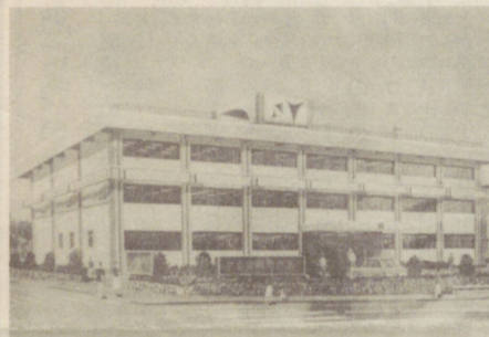
南警察署新設
