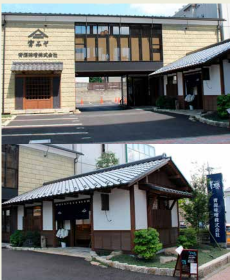
本社工屋外観
