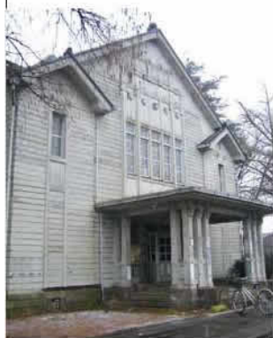
旧講堂。現在、改修工事が行われている。
