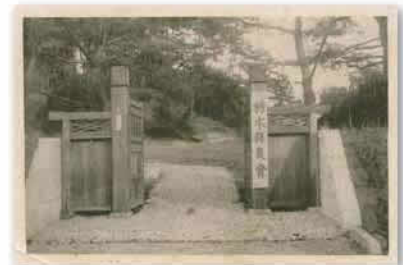
栃木県農会正門。 総工事費1万8117円37銭と記録されている
