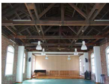
多目的ホールに改修された内部
