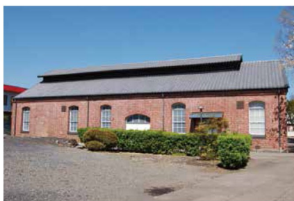
改修後の赤レンガ倉庫
