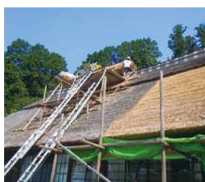
茅葺き屋根の修理
