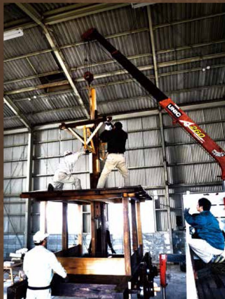
躯体組み立ての様子
