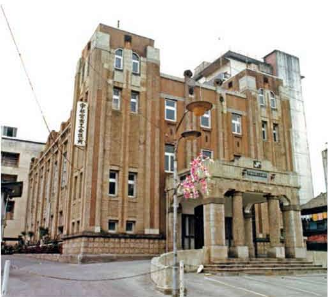
解体前の旧宇都宮商工会議所(前藤原設計事務所提供)
