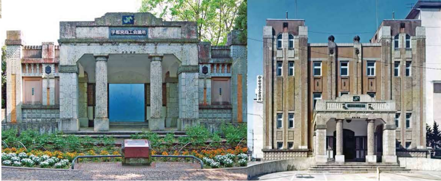
写真左/現在、栃木県中央公園に残る、旧宇都宮商工会議所の玄関部分(橋本優子氏提供) 写真右/解体前の旧宇都宮商工会議所(㈱藤原設計事務所提供)
