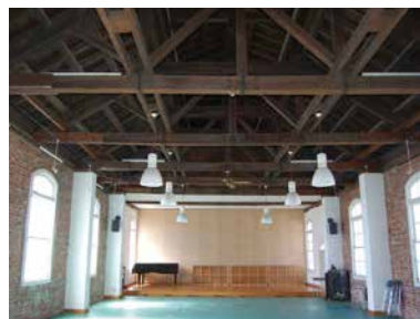
多目的ホールに改修された内部
