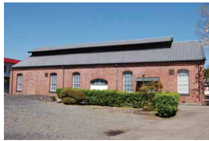
改修後の赤レンガ倉庫
