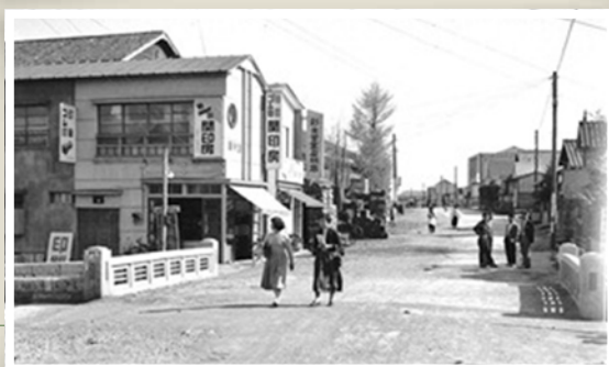
▲オリオン通りから新橋（改修後）を望む（昭和30年）
