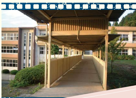
旧境中学校の渡り廊下
