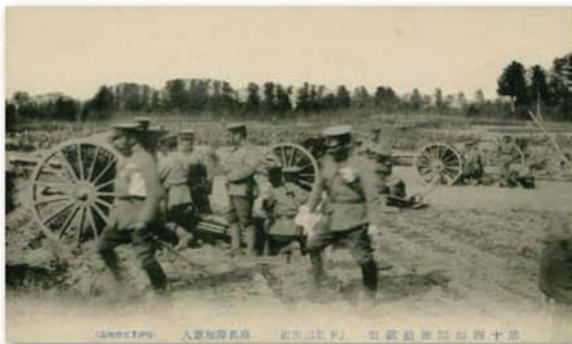
下新田付近で行われた砲兵陣地進入
