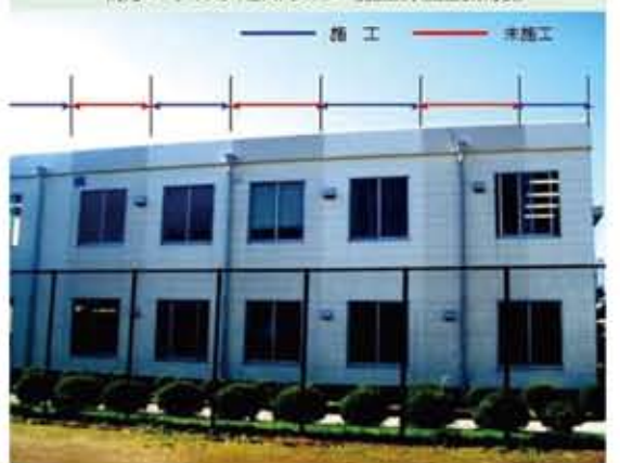
壁などの汚れを抑制する防汚用途の光触媒、防汚コーティング「ビストレイター」施工例(施工6ヵ月後)
